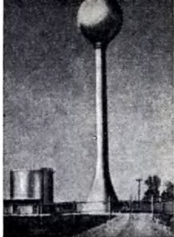
Цельнометаллическая водонапорная башня в американском штате Техас. Высота — 35 м.
